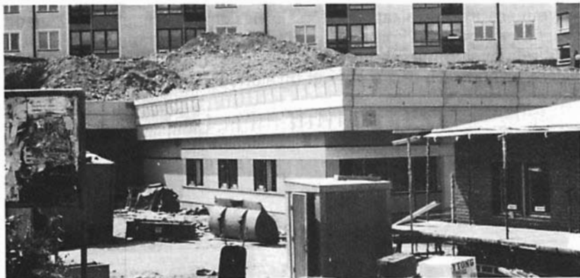
Lokaler under byggnation.
